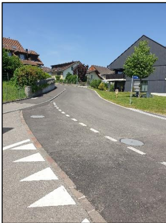
Sanierungsbereich 1. Etappe Nord
